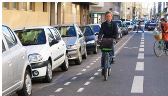
Bande cyclable avec espace tampon de 50 cm
