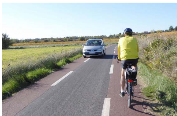
Chaussée à voie centrale banalisée
